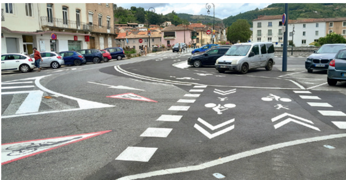
Aménagement du pont neuf – Boulevard de Verdun.
